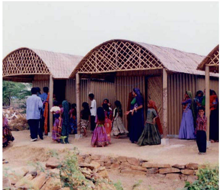
Typehuse i paprør. Arkitekt: Shigeru Ban. Kobe, Japan (1994)
